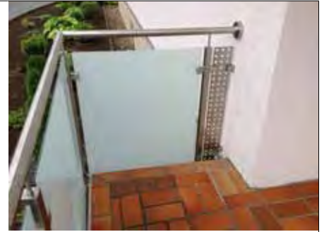
83 06 51 Rohr V2A, Ø 42,4 mm
