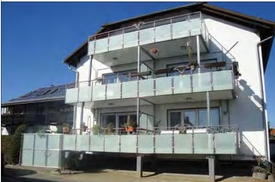
83 06 51 Rohr V2A, Ø 42,4 x 2,0 mm 83 05 55 Handlaufträger V2A 83 20 65 Glasklemme V4A (ähnlich)
