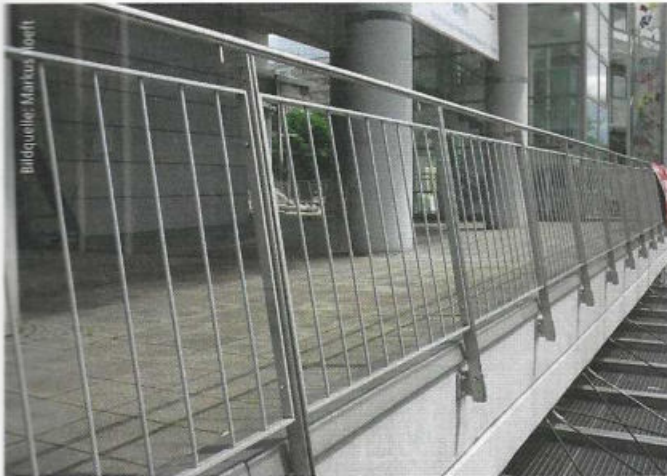
Mit großen Abständen der Füllstäbe, die aber nicht größer als 12 Zentimeter sein sollten, können sehr reduzierte Geländergestaltungen verwirklicht werden. Die Neigung des Geländers nach innen bietet in diesem Fall einen zusätzlichen Kletterschutz.
